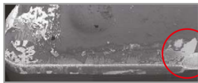
Herkömmlich C: Beschichtungsablösung
